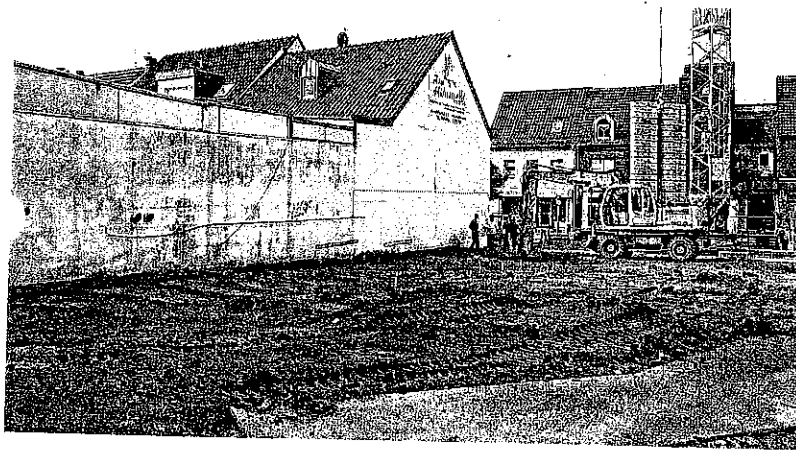
Die neue Baustelle im Stadtkern lässt von Tag zu Tag Fortschritte erkennen. Mittlerweile haben Bagger schon Erdreich ausgehoben.
